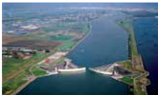
21. The Maeslantkering (part of Deltawerken) protects Rotterdam from sea water Source: rijkswaterstaat.nl
