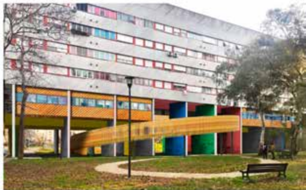
Intervento Trancia H - ante e post-operam.
