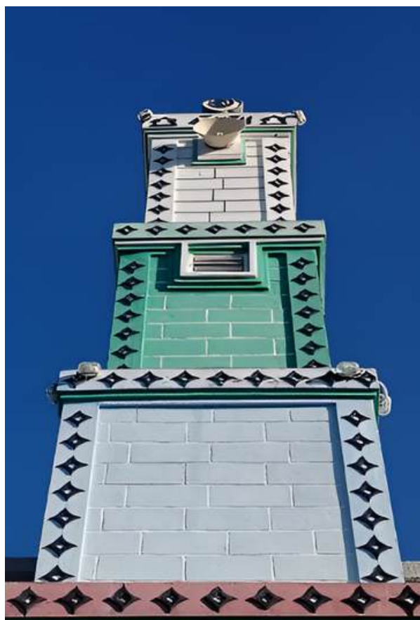
Minaret de la mosquée de Dembéli surmonté du système d'alarme. Source : mission de terrain.
