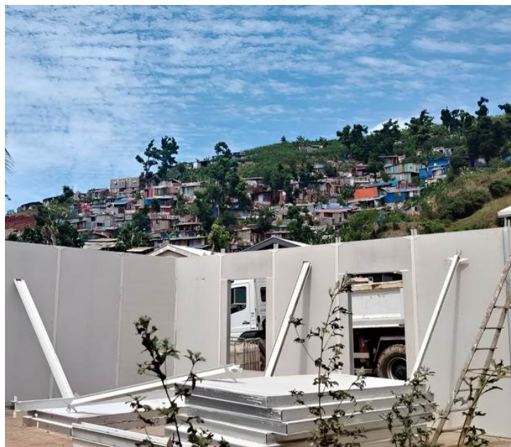
Des shelters en construction. Source : mission de terrain.
