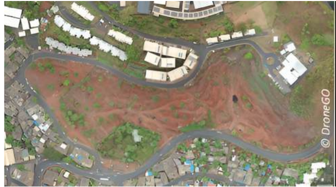
Après démolition - octobre 2021. Source : Camps et al., 2022.
