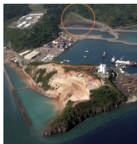
Défrichage de la mangrove au port de Longoni en 2007. Source : Marie (2019)
