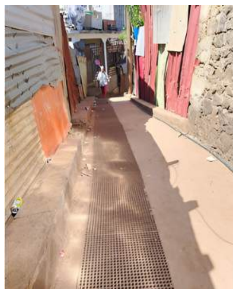
Chemin refait à neuf, avec des évacuations d'eau. Source : mission de terrain.
