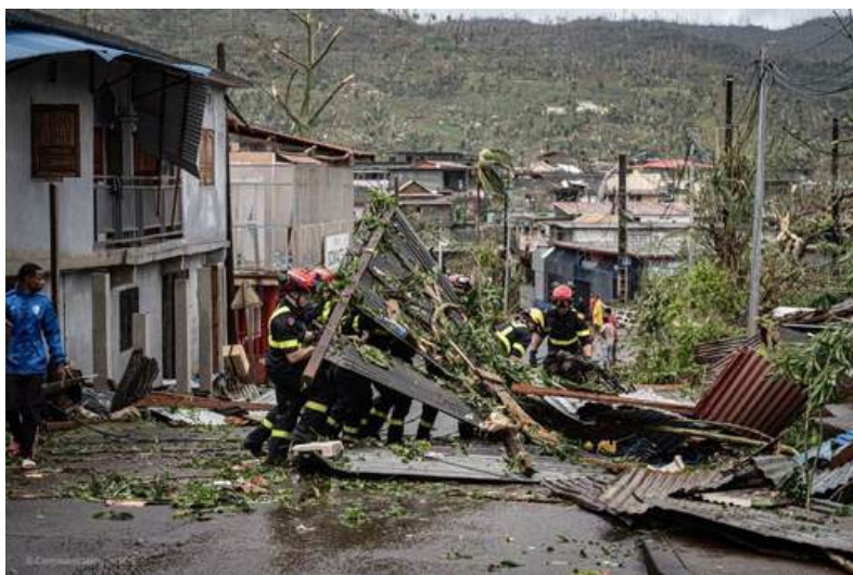
Pompiers en train de déblayer les routes à Combani, au nord-ouest de Mayotte. Source : Corvée, 2024.
