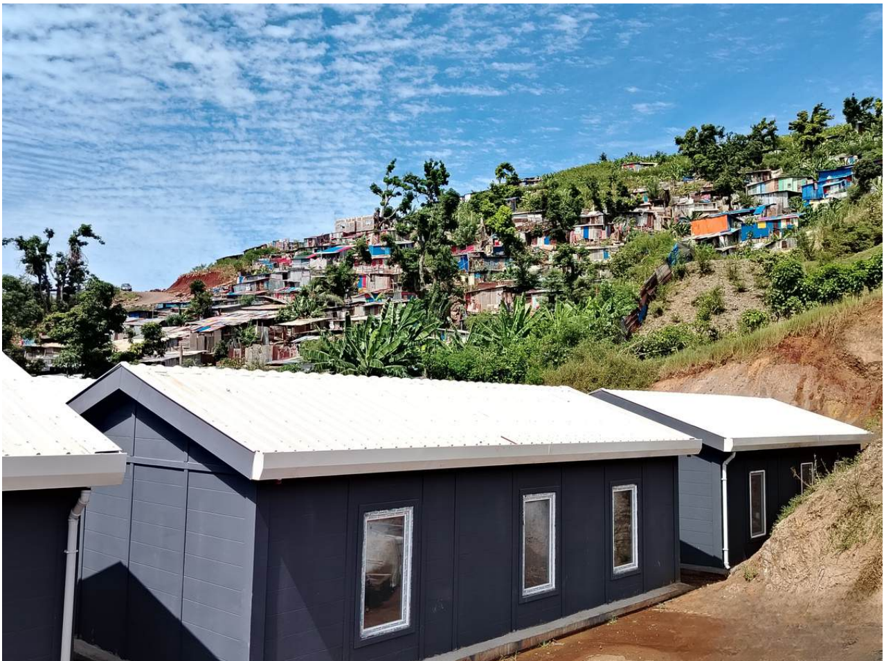
Des shelters en construction. Source : mission de terrain.
