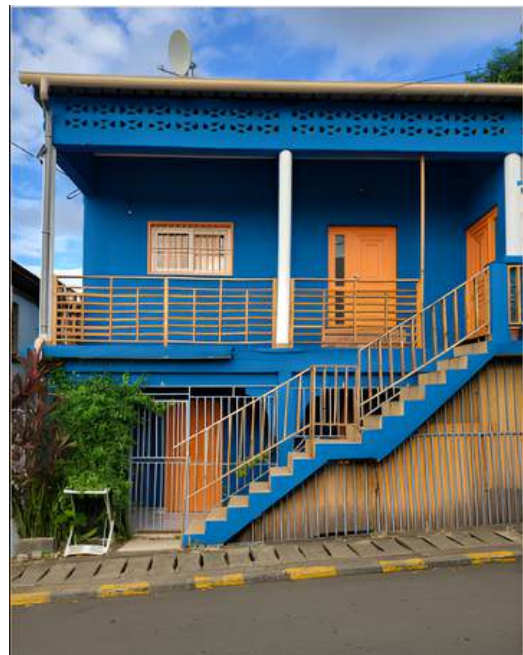
Maison récente. Source : CAUE, 2023
