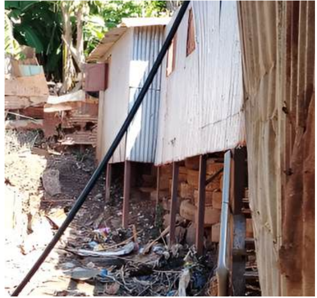
Soutènement en pneus d'une maison de Mahabourini. Source : mission de terrain.
