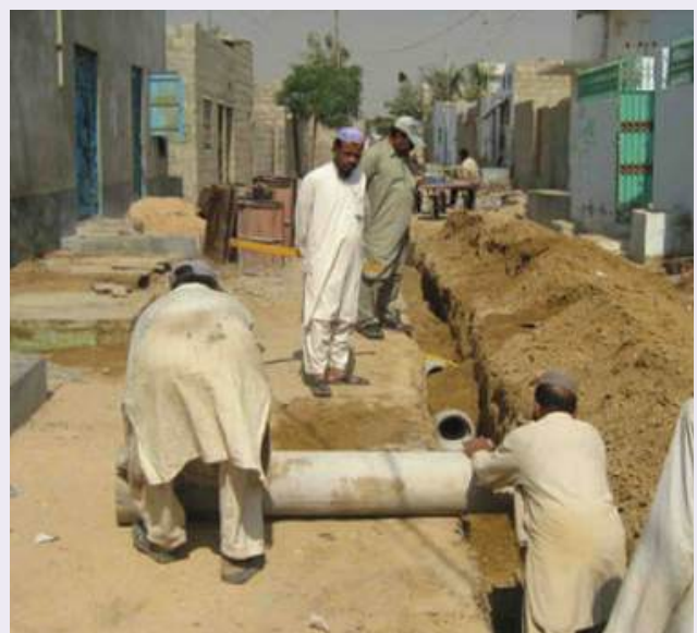
Construction d’un égout de ruelle à Gulshan-e-Zia, Karachi, par des bénévoles. Source : Diplomat, n.d..
