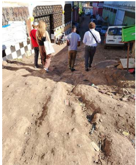
Voie sous responsabilité de l'État, impraticable pour les secours, à Majicavo Koropa. Source : mission de terrain.
